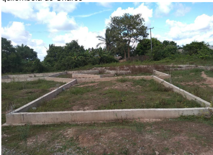
Figura 20: Foto do alicerce da construção de uma “Escola Digna” na comunidade quilombola do Charco
