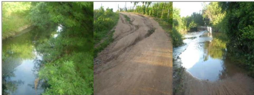
Figura 21 – Vegetação avançando sobre o canal e precariedade das vias que dão acesso aos lotes dos colonos – estradas e passagens molhadas
