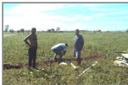
Foto 17 – Construção do acampamento Emiliano Zapata
