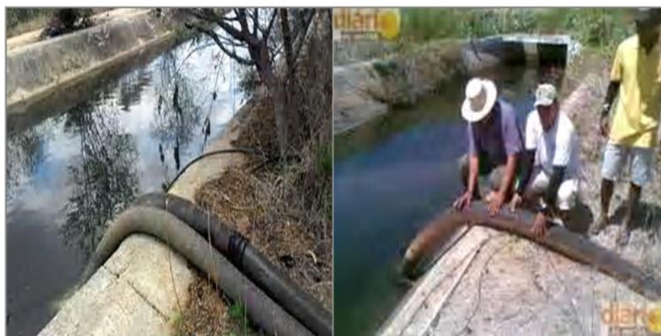
Figura 23 – Desvio ilegal das águas do Canal da Redenção
