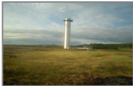
Foto 2 – Adutora de recalque e distribuição
