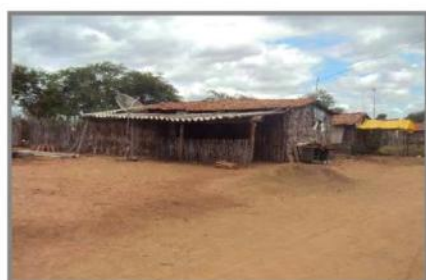
Foto 14 – Infraestrutura dos assentamentos – precariedade das habitações
