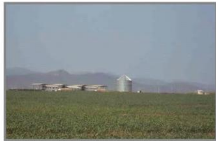
Foto 6 – Vista externa das instalações da empresa Santana, com destaque para silo com capacidade para 5 milhões de quilos de grãos
