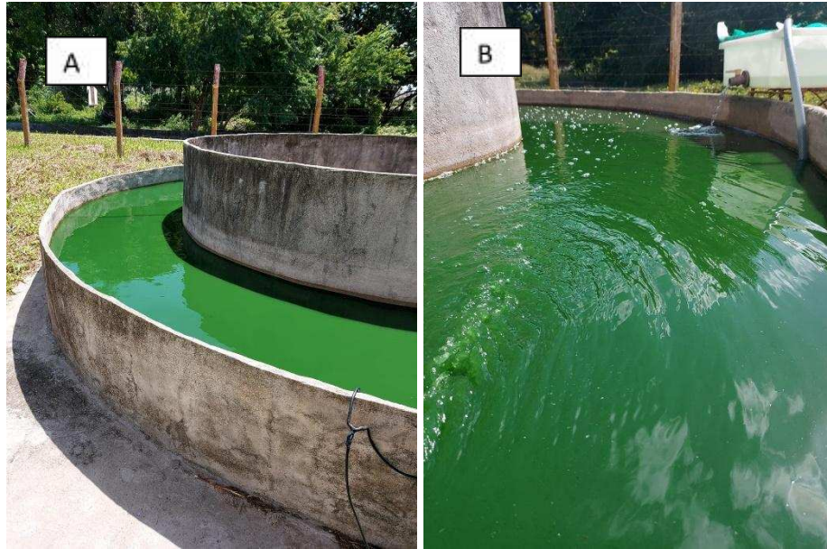
Fonte: Autor. Vista de parte da estrutura de ferro-cimento onde a A. platensis foi produzida (A). Vista da A. platensis em circulação no tanque de cultivo (B).
