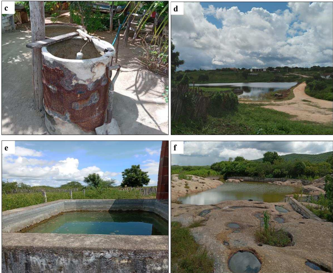
Legenda: a) Cisterna de placas para coleta e armazenamento das águas das chuvas; b) Cisterna de Enxurrada, para coleta e armazenamento das águas das chuvas; c) Tambor de alumínio para armazenar água da chuva; d) açude de pequeno porte, e) Tanque pra armazenar água da chuva f) Tanque de pedra em lajedo para armazenar água da chuva. Fonte: autora, 2023.
