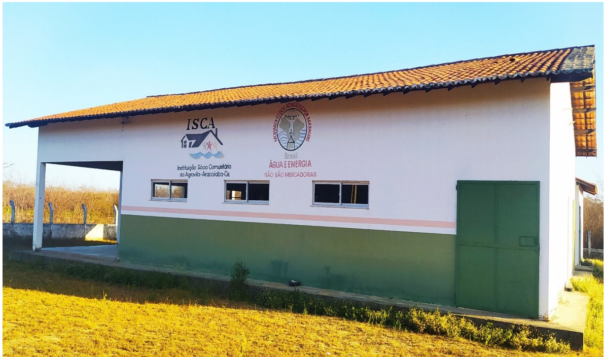
Figura 19 – Fábrica de beneficiamento de castanha construída e ainda não funcionando.
