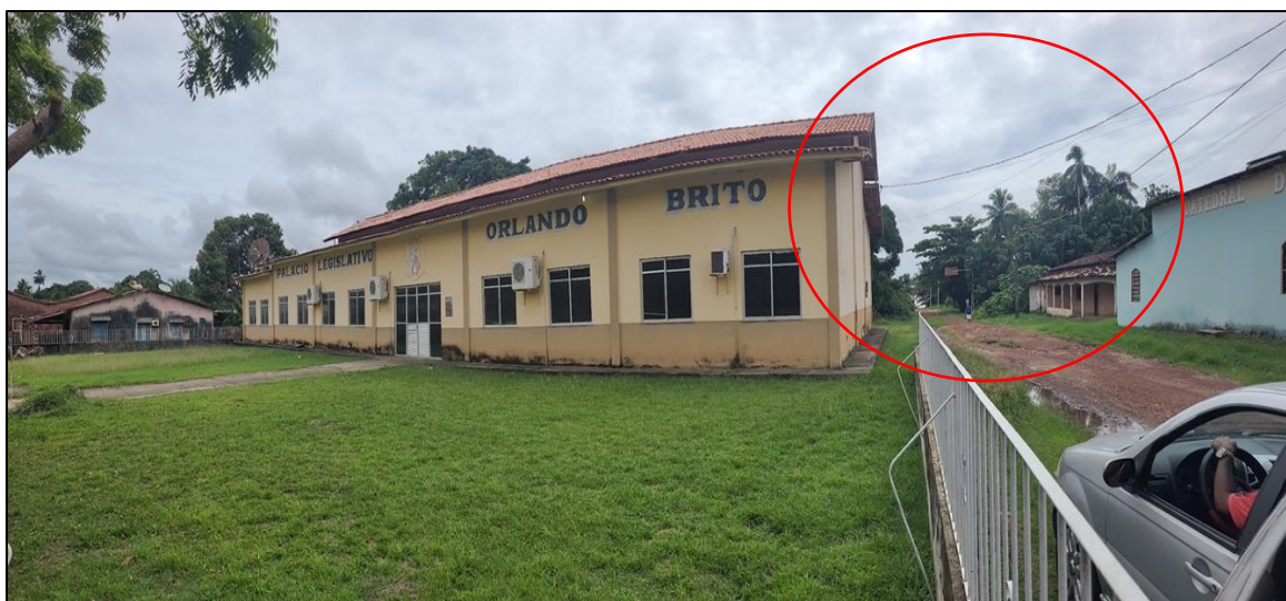
Figura 48 – Expansão urbana na zona de mangue
