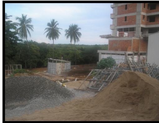
FIGURA 19 – Canteiro de obras na Eng. Santana Júnior. FONTE – LIMA, 2007.
