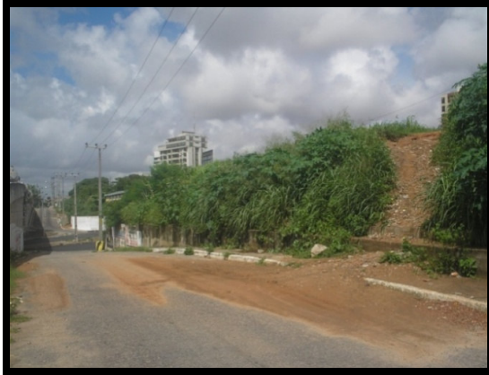
FIGURA 32 – Deslizamento de areia próximo à av. Via Expressa. FONTE – LIMA, 2007.
