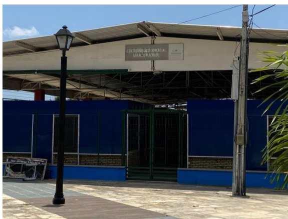
Figura 8 - Centro Público em obras
