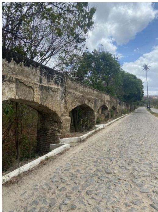
Figura 21 - Muro construído por escravos, na aldeia Santo Antônio (Maracanaú, Ceará).
