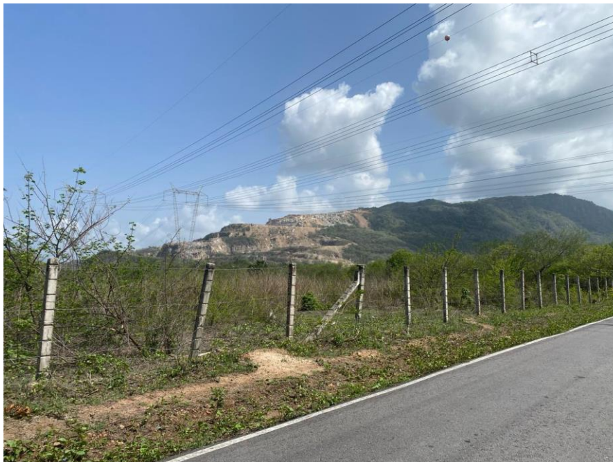
Figura 32 - Serra da Aratanha dentro do TI Pitaguary, impactos causados pela extração de britas.
