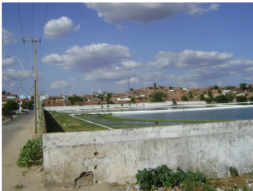
Figura 06: Conjunto de lagoas de estabilização. Fonte: Evangelista (2008).
