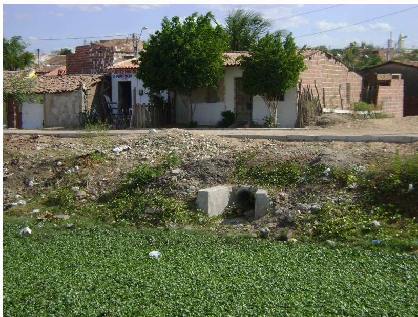
Figura 08: Esgoto sem tratamento em condições precárias, lançado diretamente ao rio Mucambinho. Fonte: Evangelista (2008).
