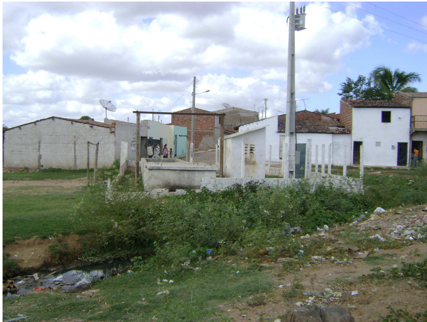
Figura 13: Estação de tratamento de água do SAAE, às margens da Lagoa do Mucambinho, tomada pela vegetação. Fonte: Evangelista (2008).
