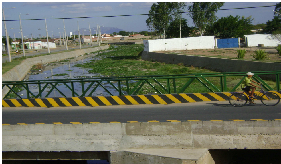
Figura 69: Canalização do rio Mucambinho na Zona Urbana do Município de Sobral. Fonte: Evangelista (2008).
