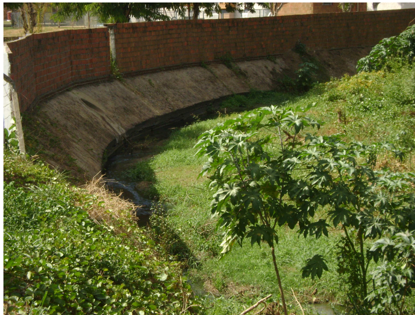
Figura 16: Canalização do rio após o açude Mucambinho. Fonte: Evangelista (2008).
