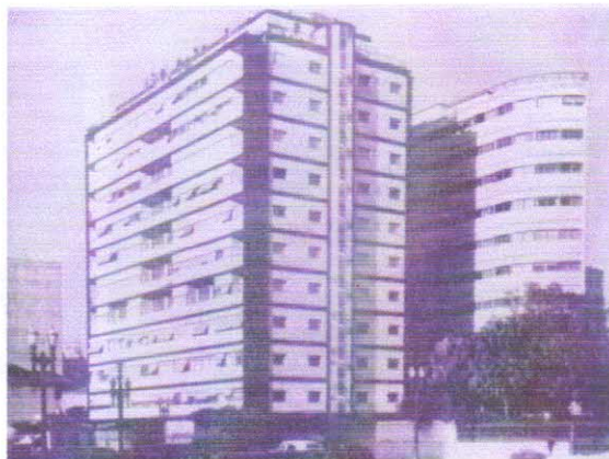
Foto do Edifício Esther
