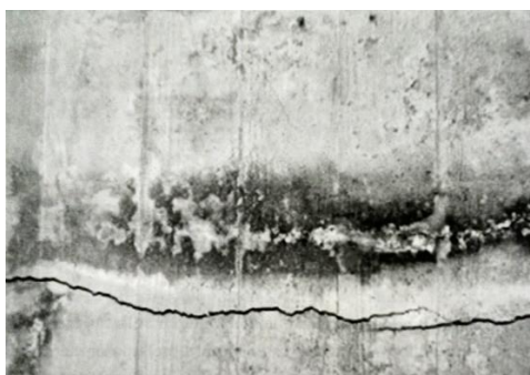
b) Expansão por sulfato. Fonte: Bolina, Tutikian e Helene (2019).
