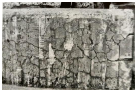
c) Reação álcali-agregado (RAA). Fonte: Bolina, Tutikian e Helene (2019).
