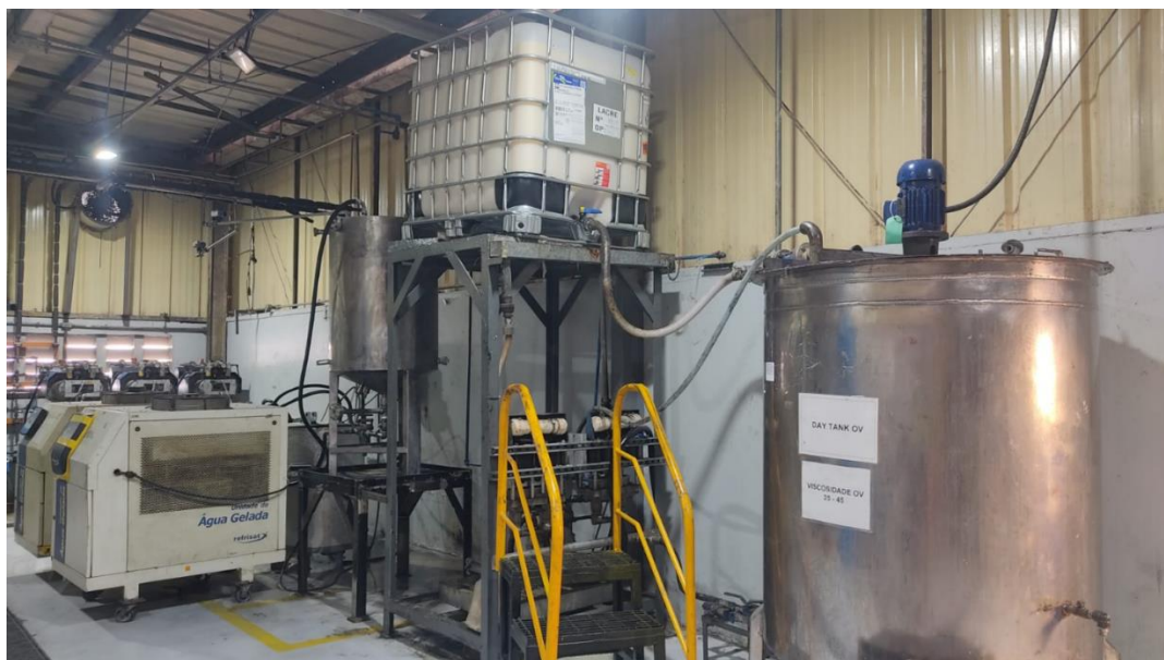
Figura 6 - Realocação do tanque do verniz. Fonte:Autor (2023)
