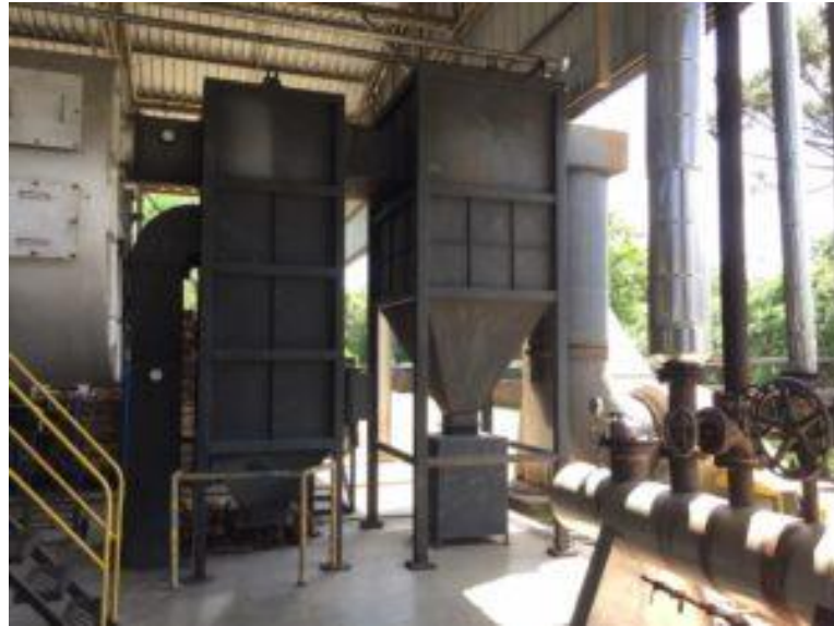
Figura 4- Pré-aquecedor de ar SFW
