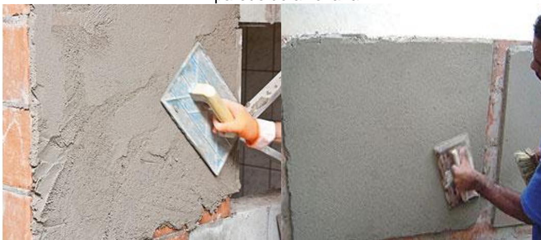
Figura 2.3 – Utilização de argamassa de revestimento na confecção de parede de alvenaria
