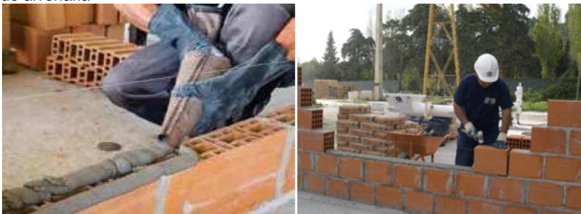
Figura 2.2 – Utilização de argamassa de assentamento na confecção de parede de alvenaria
