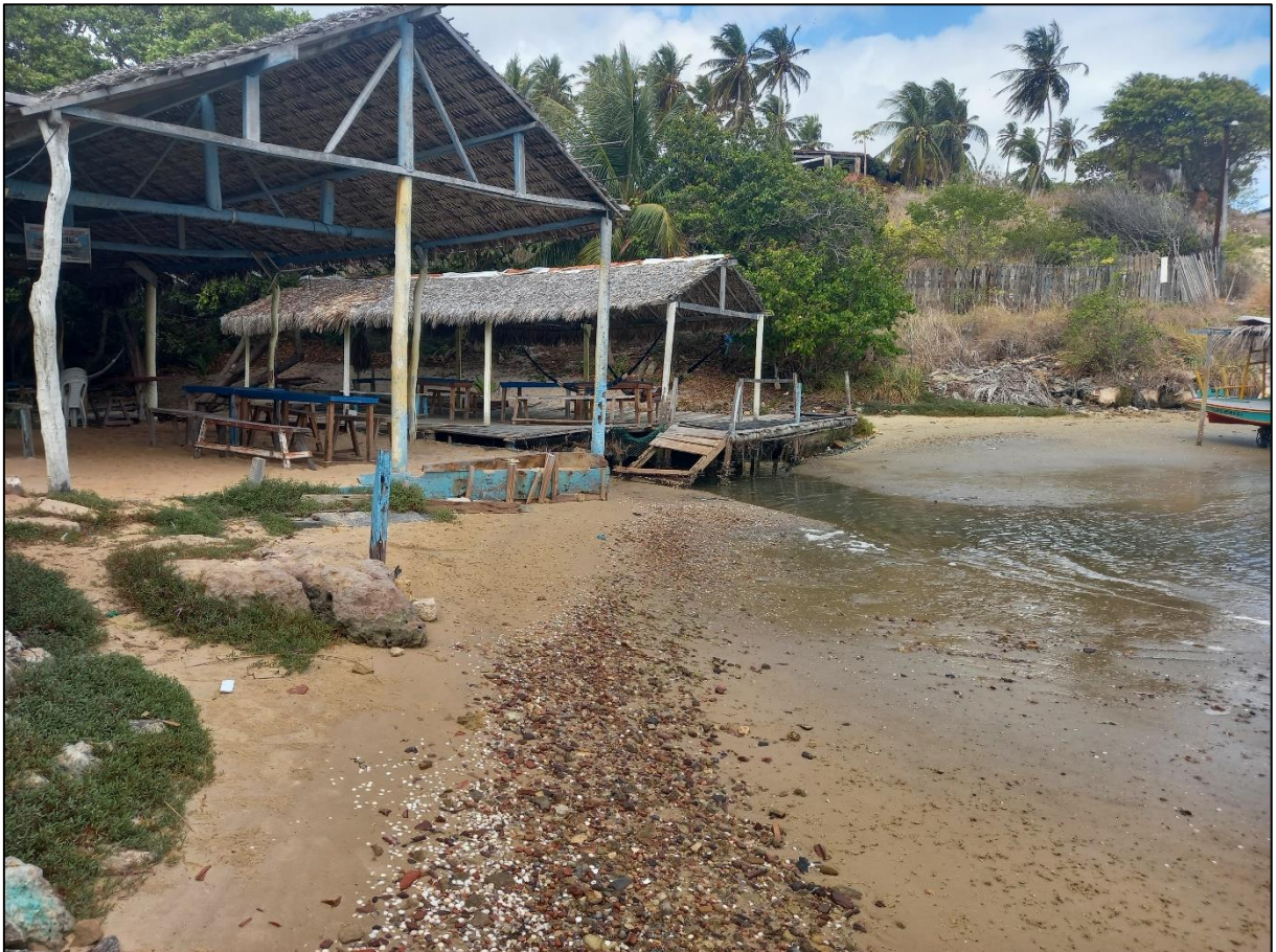
Figura 11 – Depósito aluvionar sob infraestrutura instalada às margens do rio Jaguaribe em Fortim
