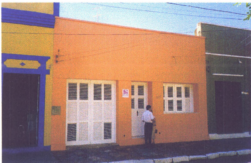
Edificação Descaracterizada (rua Cel. Alexanzito)
