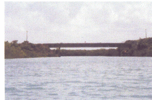
PONTE SOBRE O RIO PACOTI
