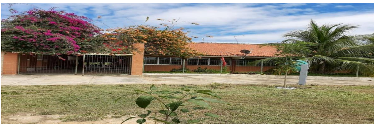
Figura 1 – Fachada da EEM João dos Santos de Oliveira
