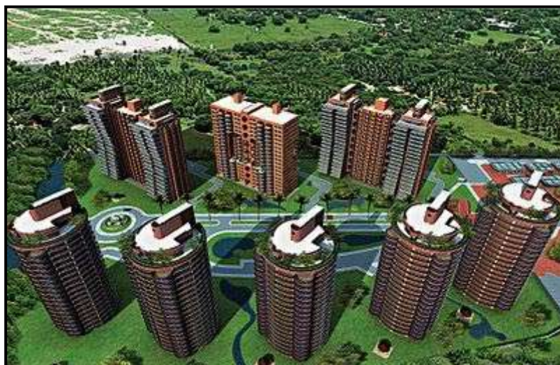
FIGURA 23: Empreendimento Quintas das Fontes. Quando lançado, em 2005, foi anunciado como o maior empreendimento residencial da RMF. Fonte: Divulgação DDC Brasil, 2005.
