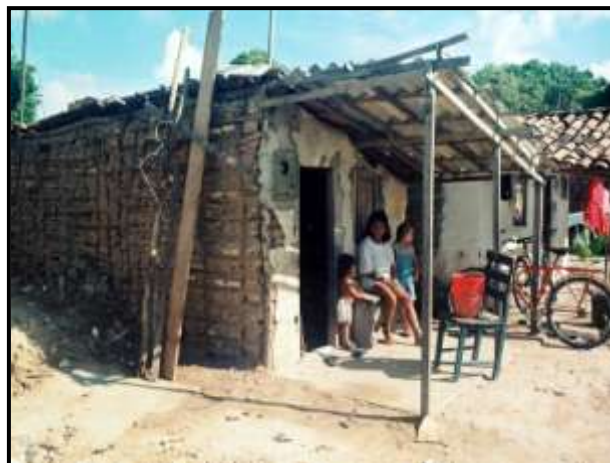
FIGURA 9: Moradias Precárias na localidade de Guaribas. Fonte: Brito (1990)
