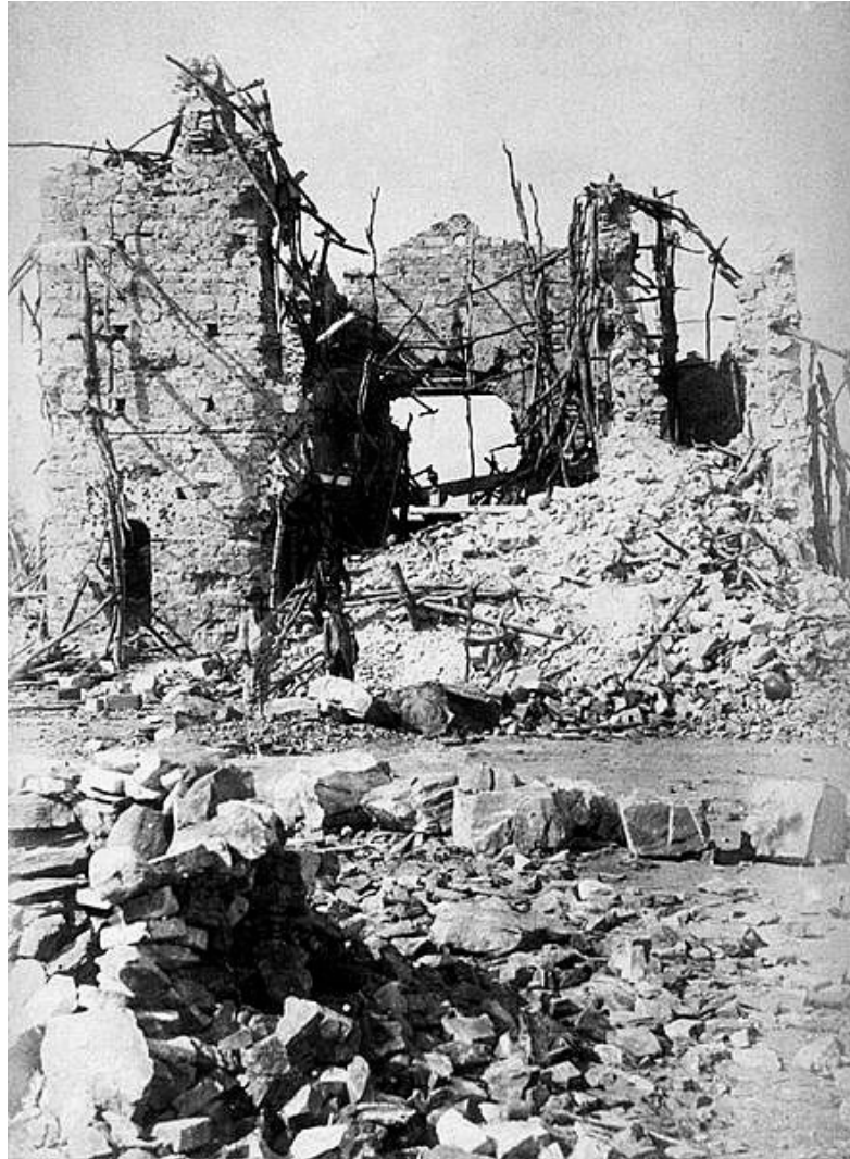
Fotografia 4 – Ruínas da Igreja do Bom Jesus (“Igreja Nova”).
