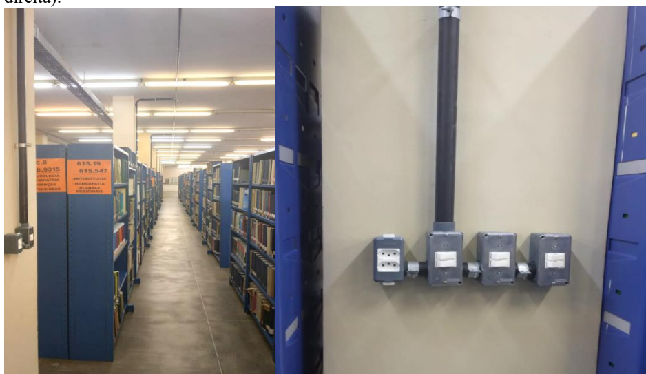
Figura 25 - Iluminação das estantes com a nova organização (à esquerda) e interruptores de fácil acesso no ambiente (à direita).
