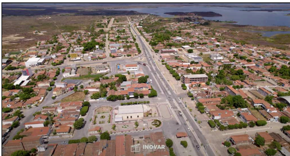
Figura 2 – Imagem aérea da zona leste da cidade de Varjota-CE
