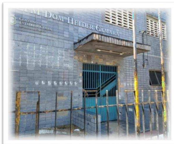
Figura 3 – Fachada da escola antes do início da reforma
