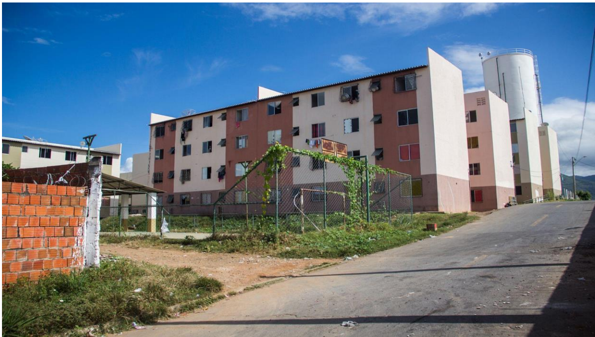
Figura 12 – Um dos acessos ao Residencial Nova Caiçara.
