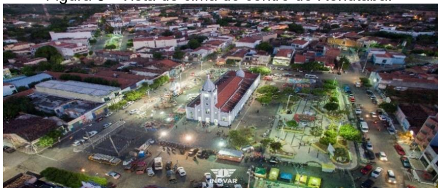
Figura 5 - Vista de cima do centro de Reriutaba.
