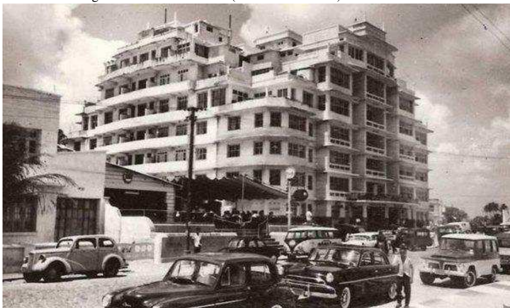
Fig. 4: Iracema Plaza Hotel (Edifício São Pedro) na década de 50.
