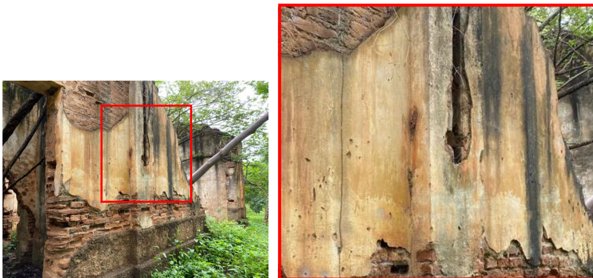
Figura 117 – Fachada e pilar com marcas do engaste da mão-francesa
