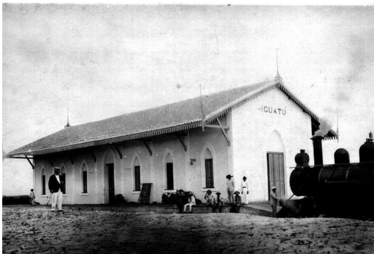
Figura 191 – Estação de Iguatu: pináculos, lambrequins, mão-francesa e sino
