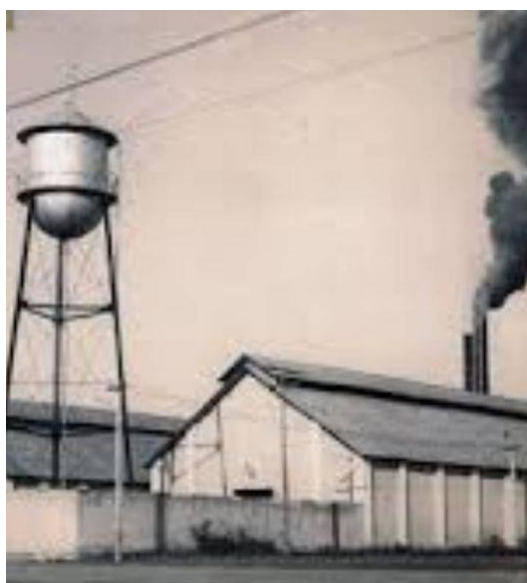
Figura 240 – CIDAO: caixa d’água pré-moldada, chaminés e galpões com sheds
