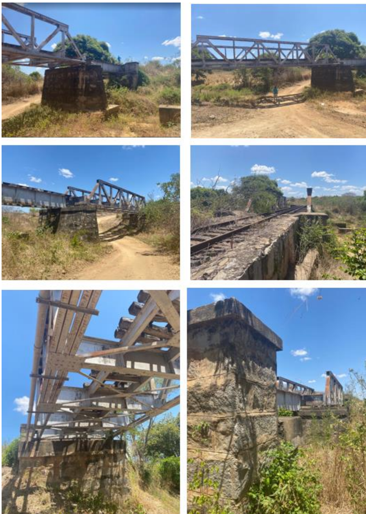
Figura 51 – Ponte mista e vestígios da base da ponte provisória sobre o riacho Santo Antônio, no sítio Santa Cruz
