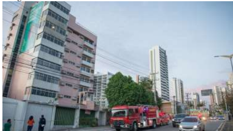
Figura 4 – Fachada de Edifício desaba em Fortaleza/CE
