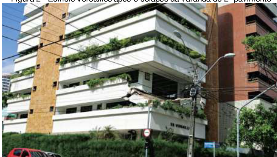
Figura 2 - Edifício Versailles após o colapso da varanda do 2º pavimento
