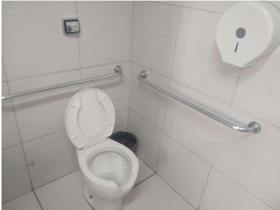
Figura 39 – Banheiros acessíveis na edificação
