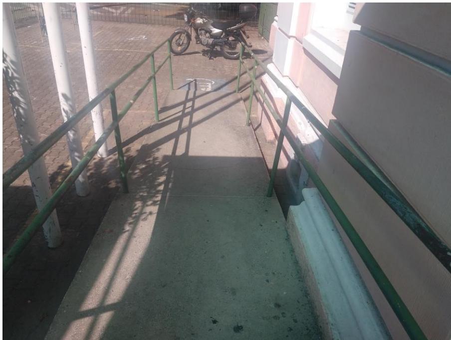
Figura 38 – Presença de rampas de acesso na edificação
