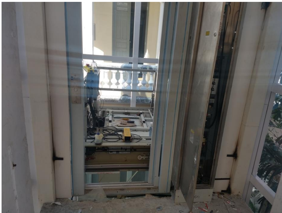
Figura 40 – Instalação de plataforma de elevação na edificação
