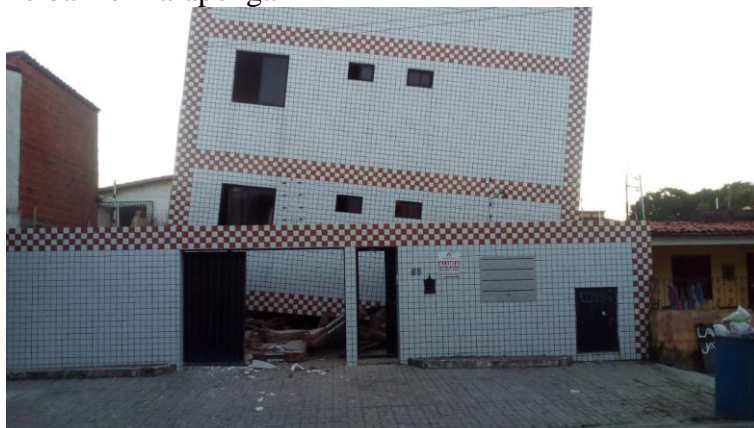
Figura 4 – Desabamento parcial de um edifício residencial no bairro Maraponga
