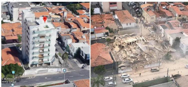
Figura 5 – Desabamento total de um edifício residencial no bairro Dionísio Torres
