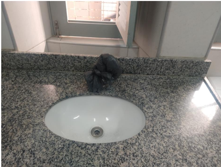
Figura 36 – Presença de fissuras verticais em alguns encontros de paredes
