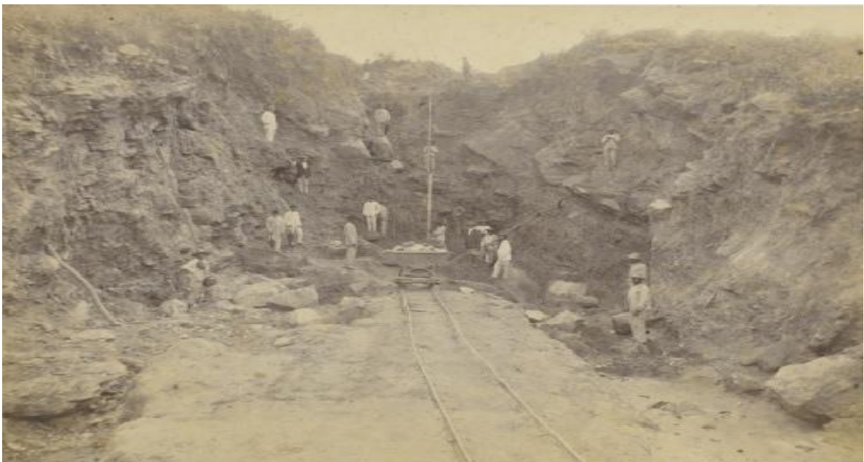
Figura 2: Trabalhadores da Inspetoria de Obras Contra as Secas na construção do açude Acarape no Estado do Ceará, em 1910.
