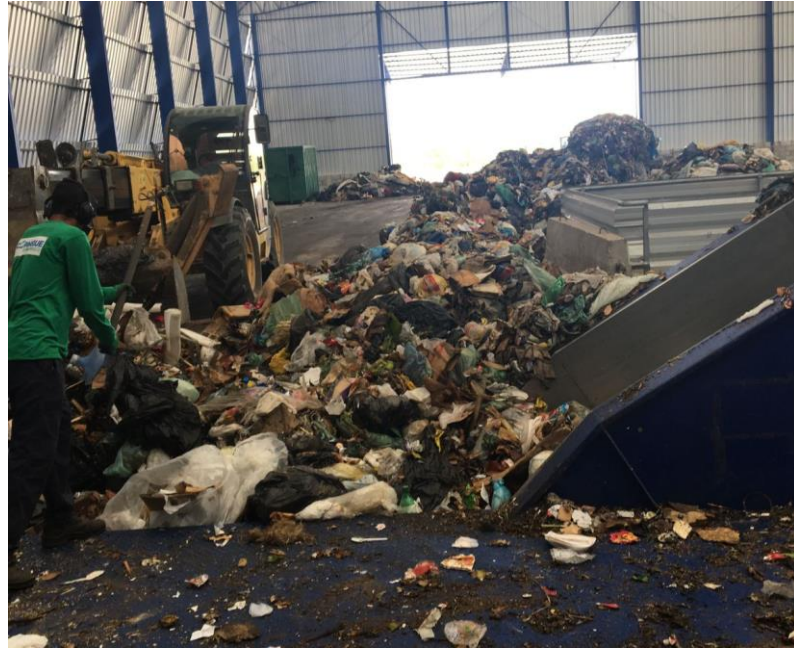
Figura 27 – Alimentador primário do Ecoparque de Pernambuco.
