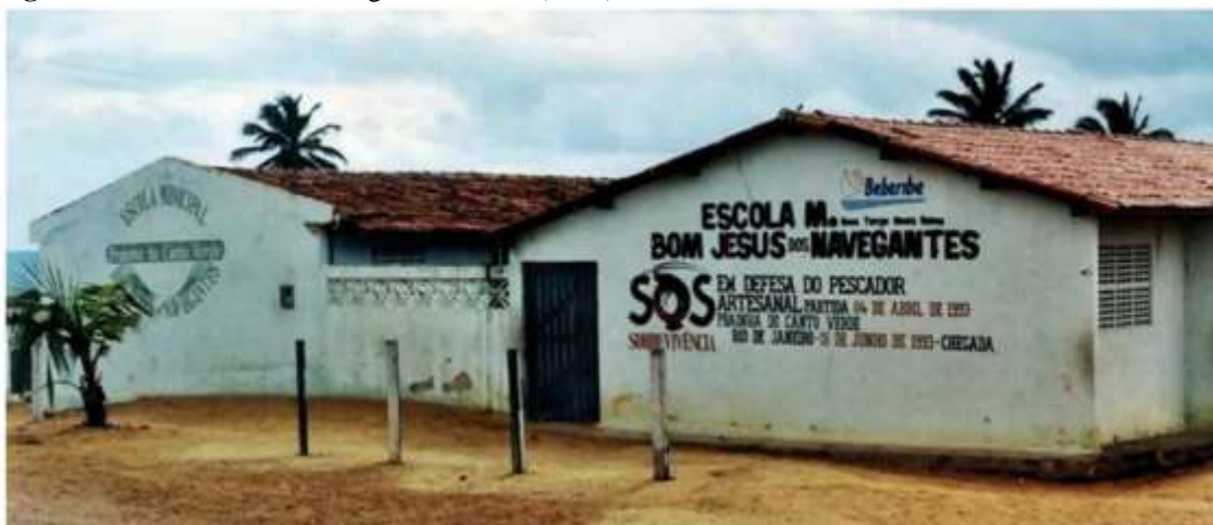
Figura 7 - Prédio da escola antiga, reformado (1986)
