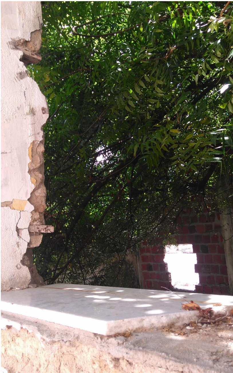
Figura 20 - Acesso visto do interior, pela janela.
