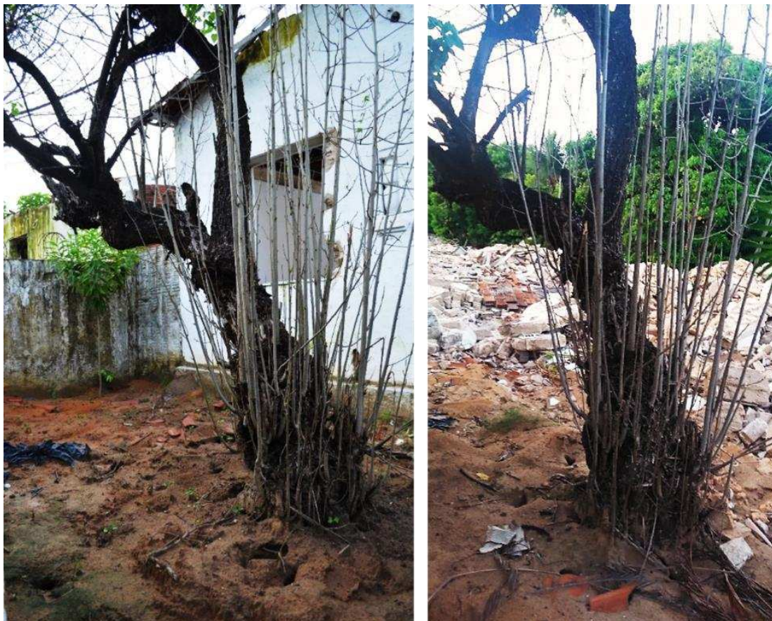
Figura 15 - Antes e depois de uma ruína com formigueiro.
