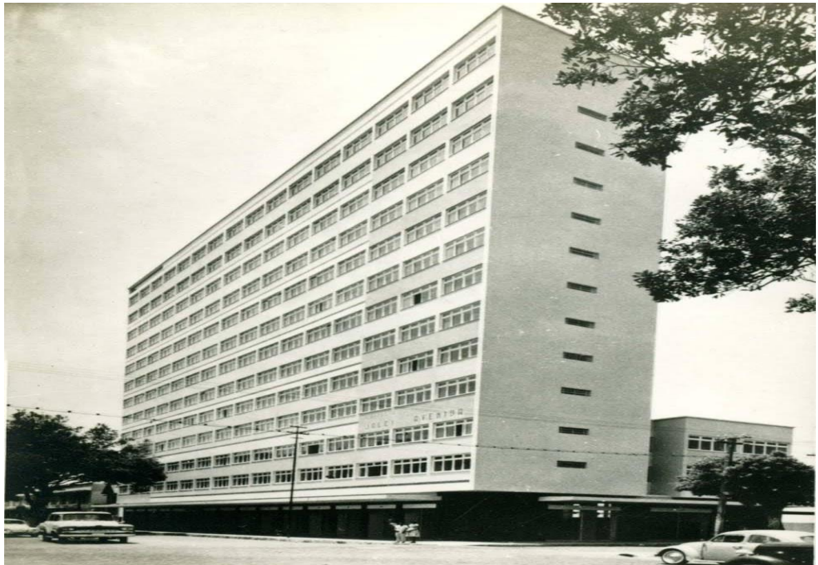
Figura 16: Fachada do Ed. Jalcy Avenida, onde, no térreo funcionava o Bar Balão Vermelho
