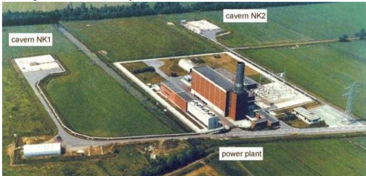
Figura 45 – Vista aérea da planta CAES de Huntorf
