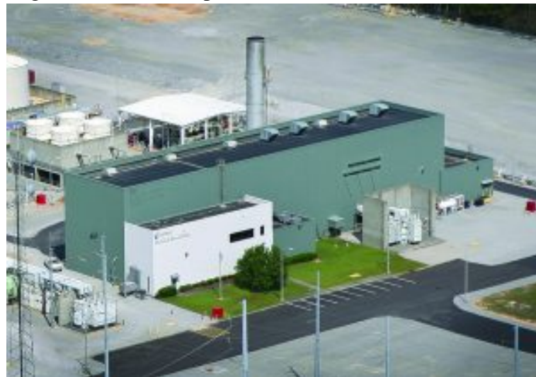
Figura 46 – Vista da planta CAES de McIntosh
