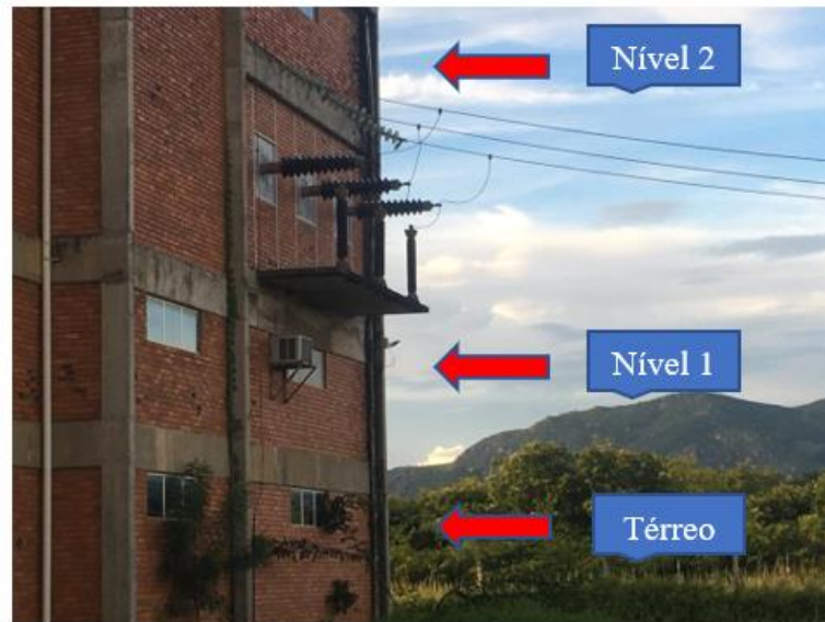
Figura 10 - Ramal de entrada SE 69kV
