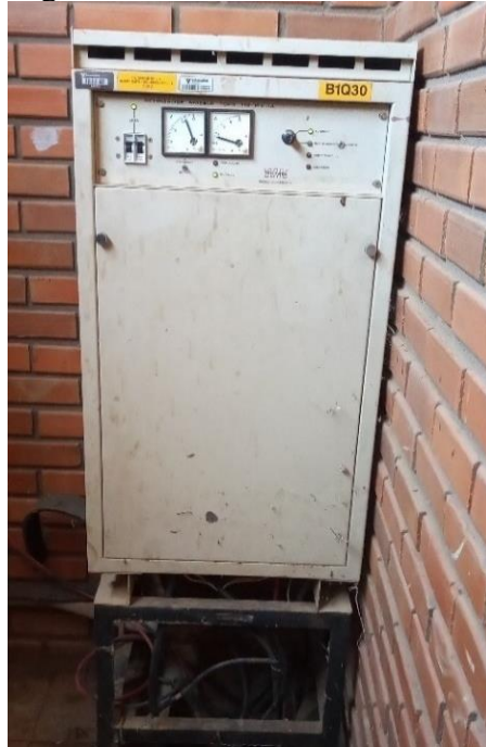
Figura 17 - Retificador de baterias
