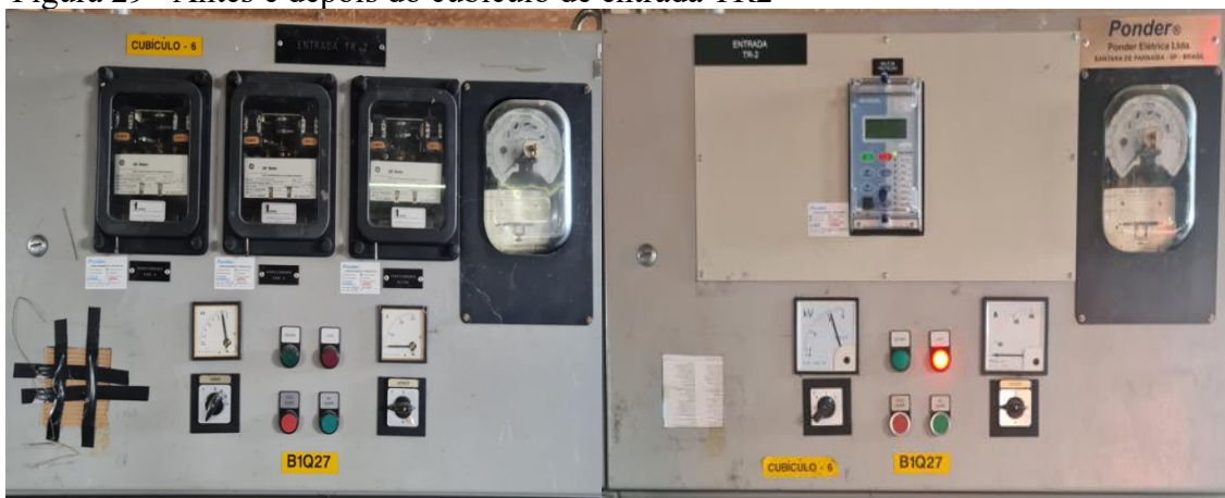
Figura 29 - Antes e depois do cubículo de entrada TR2
