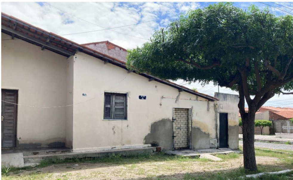
Figura 14 – Fachada de uma unidade habitacional do Conjunto COHAB
