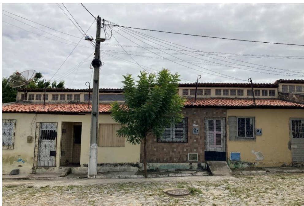
Figura 16 – Fachada principal das unidades habitacionais do DERT.
