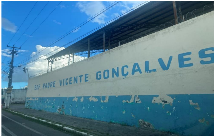
Figura 25 – Fachada da Escola de Ensino Fundamental Padre Vicente Gonçalves
