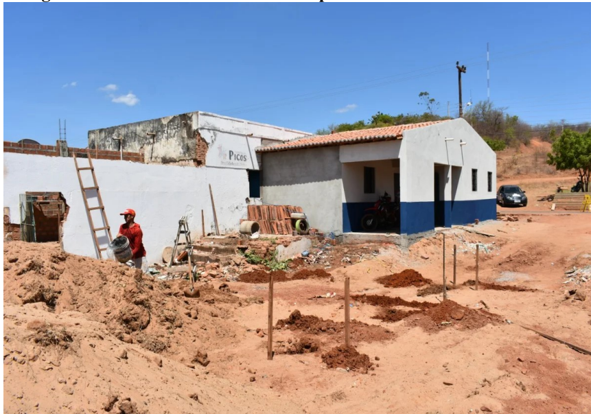
Figura 3 – Reforma da Escola Municipal Nossa Senhora dos Remédios
