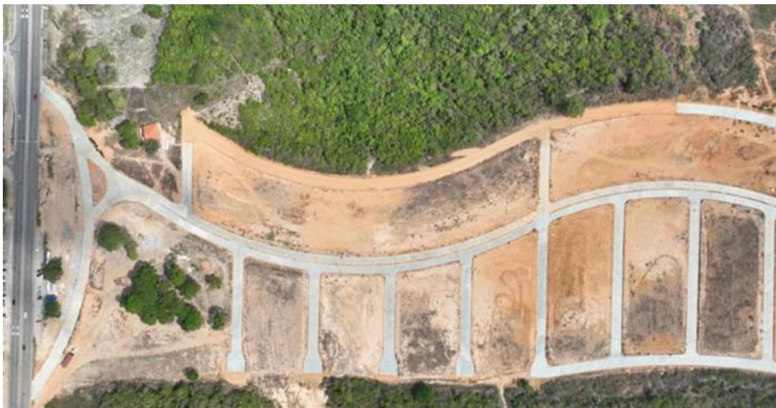
Figura 8 - Área em processo de edificação às margens da CE-090, em Caucaia
