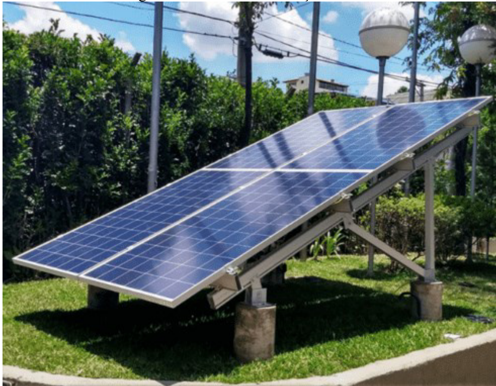
Figura 7 – Estrutura de fixação de solo
