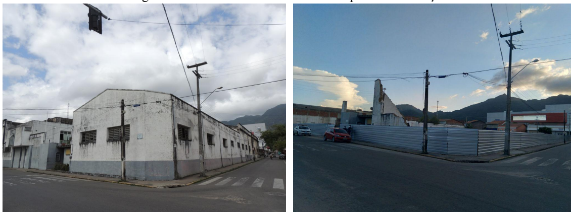
Figura 6 - Estrutura da fábrica antes e depois da demolição
