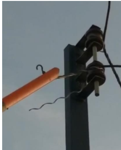
Figura 18 - Cabo levado até a Roldana
