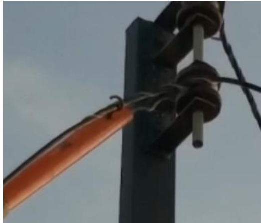
Figura 19 - Amarração do cabo a Roldana
