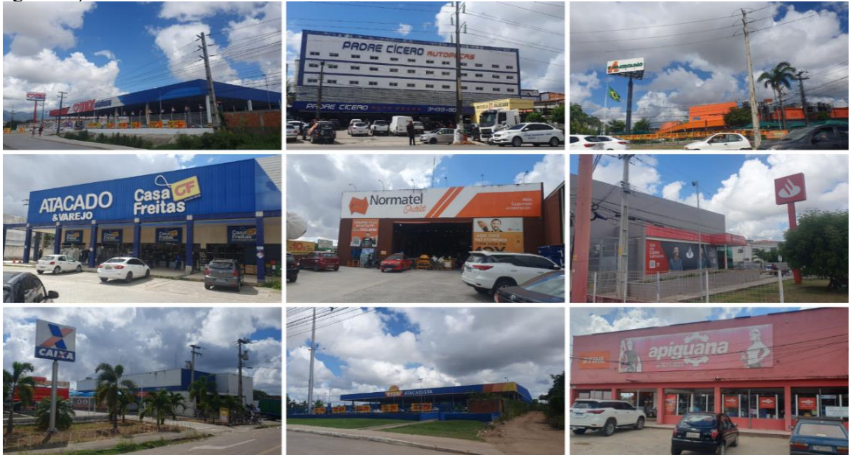
Figura 14 - Fixos terciários na Rodovia Doutor Mendel Steinbruch em Maracanaú na zona de aglutinação com Fortaleza
