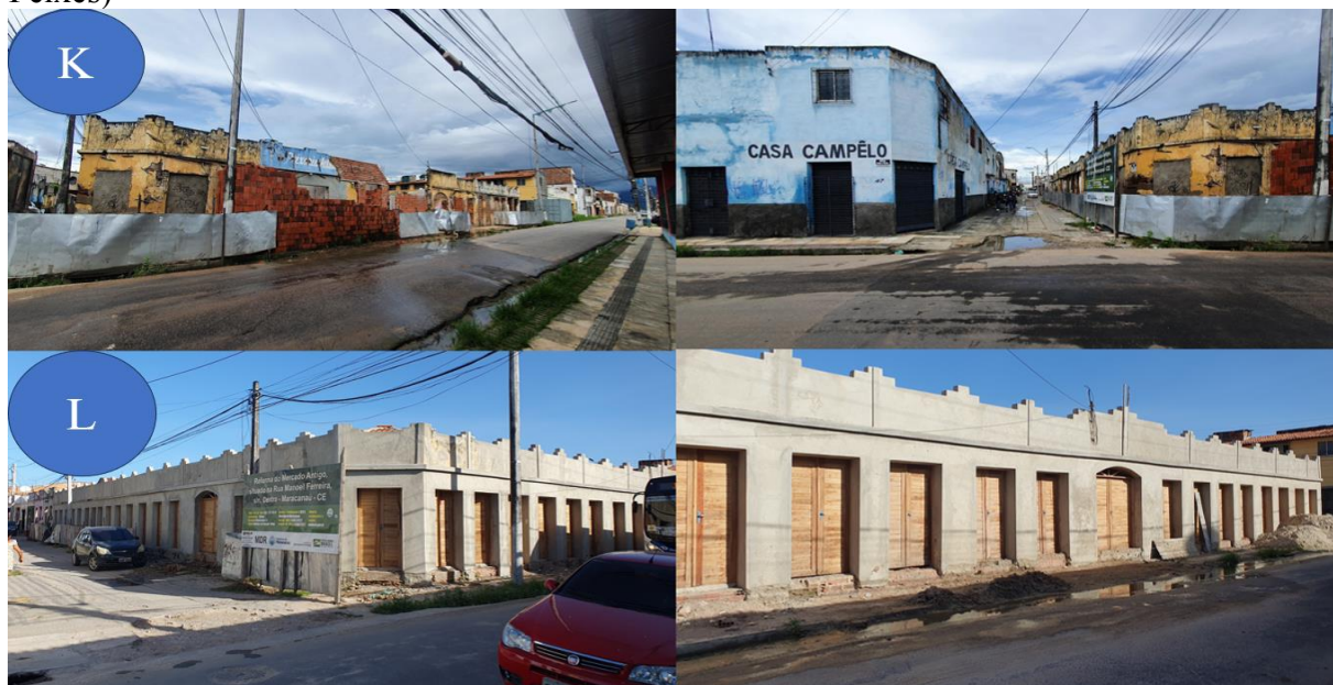
Figura 49 – Obra de requalificação do antigo Mercado Público de Maracanaú (Mercado dos Peixes)
