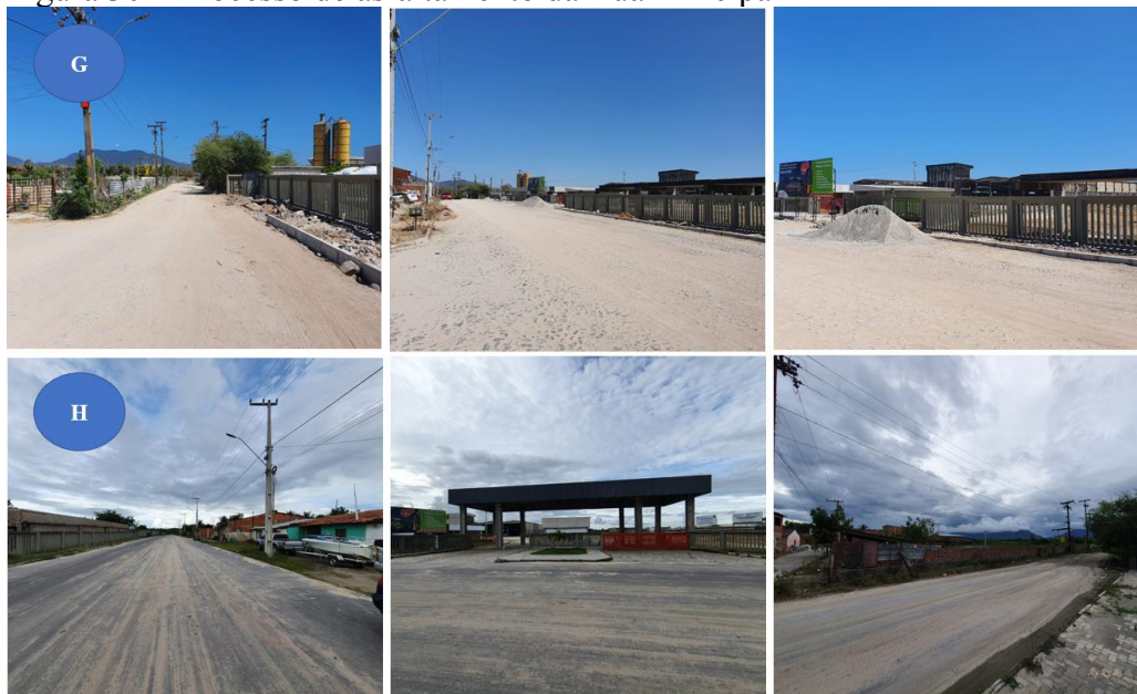
Figura 30 – Processo de asfaltamento da Rua Principal
