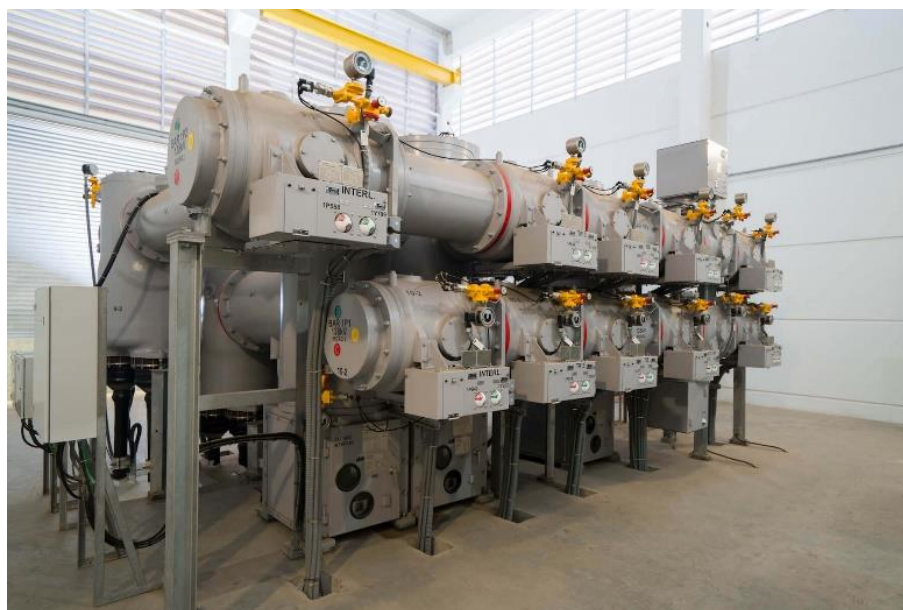
Figura 9 – Exemplo de subestação GIS
