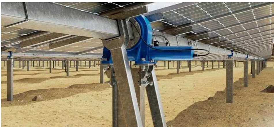
Figura 8 – Fixação de módulos fotovoltaicos em sistemas com rastreamento solar
