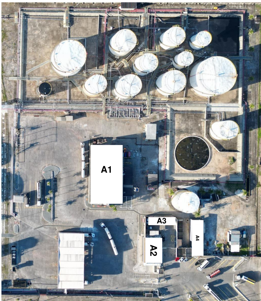
Figura 14 - Áreas de Instalação do SFCR.
