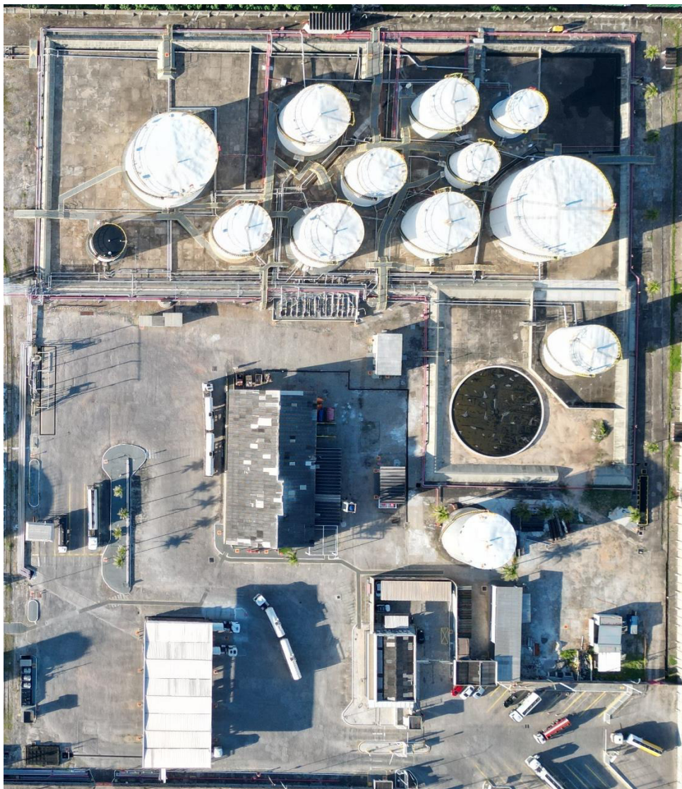
Figura 12 - Vista aérea da Distribuidora de Combustíveis.
