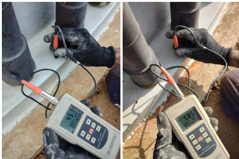
Figura 56 - Medições Máxima e Mínima de Espessura Seca.
