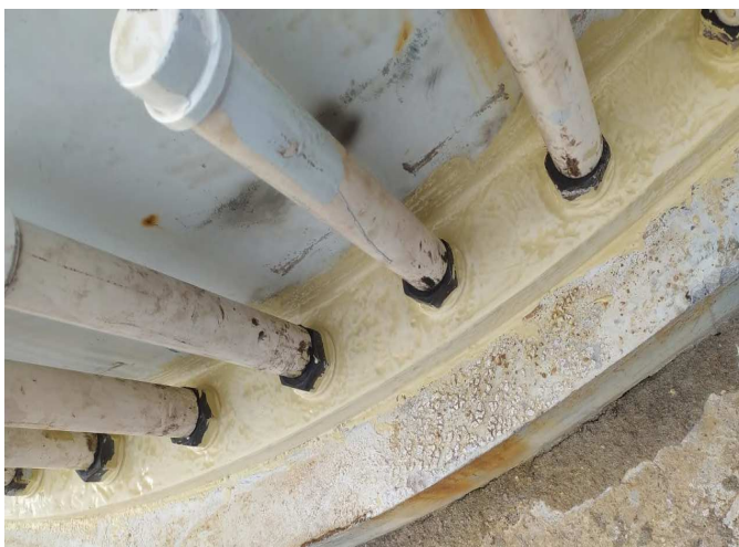
Figura 48 - Base com Aplicação de Fundo Após a Chuva.
