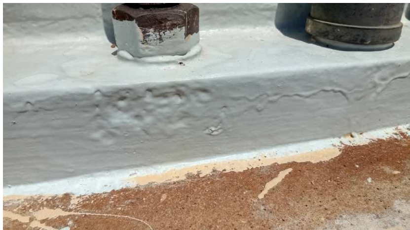
Figura 50 -Imperfeições na Superfície Pintada.
