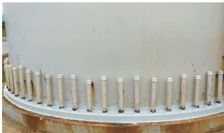
Figura 40 - Aplicação de Acabamento Finalizada.
