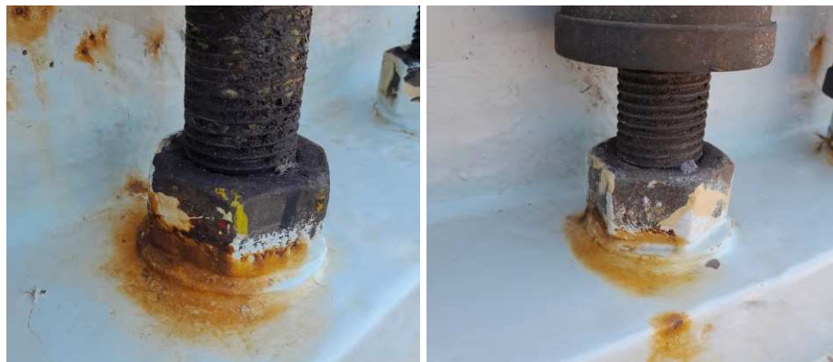
Figura 60 - Retorno de Oxidação em Volta da Porca.
