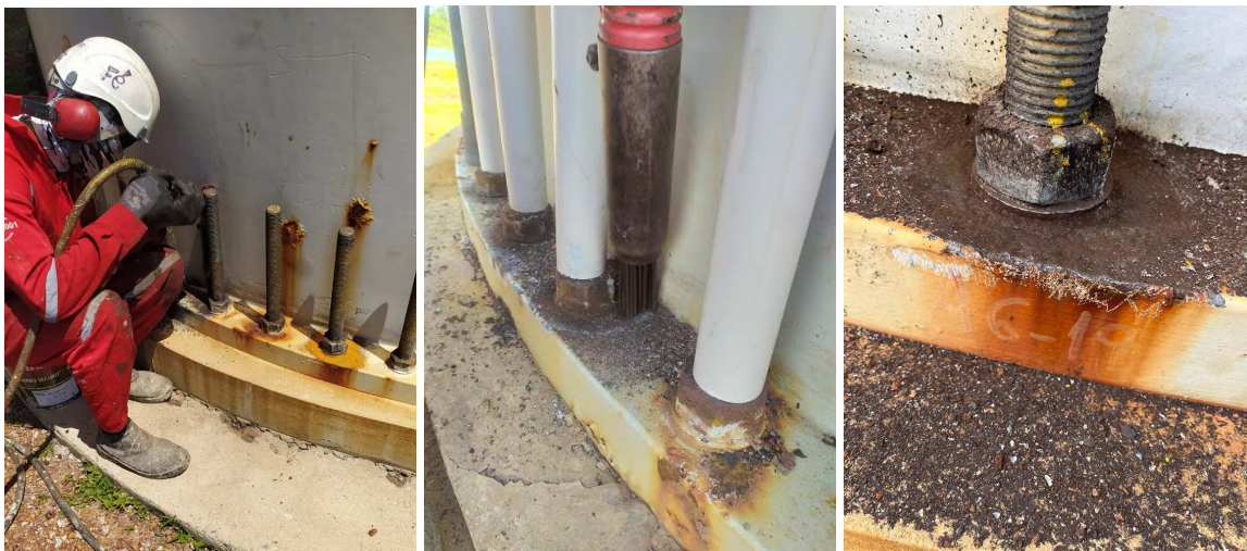
Figura 25 - Utilização de Desincrustador Pneumático.
