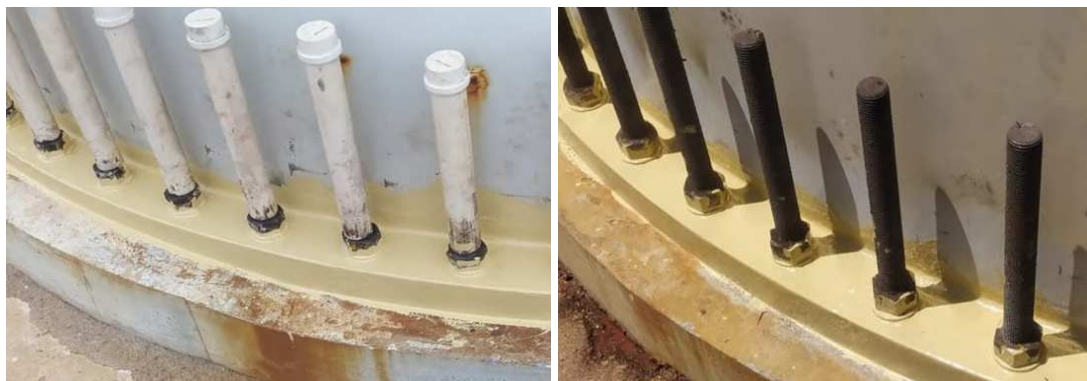
Figura 34 - Tinta de Fundo Após Aplicação.
