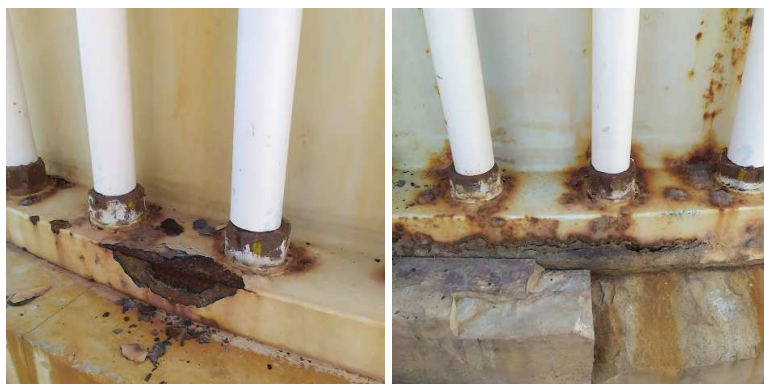
Figura 21 - Estado Inicial da base.
