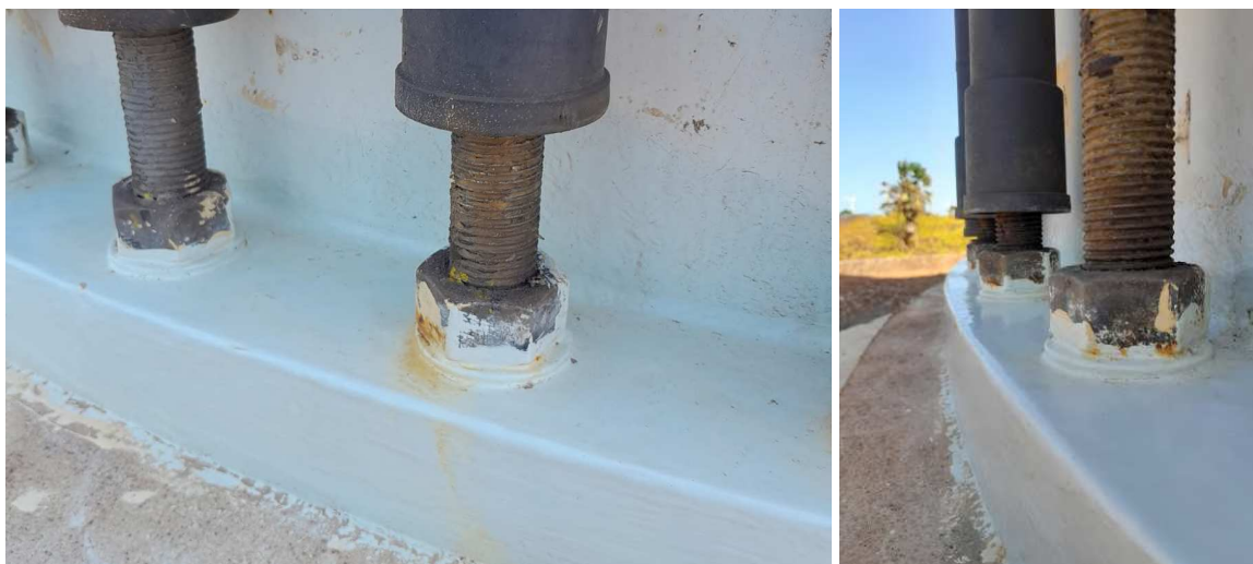
Figura 63 - Inspeção Base Torre 06.
