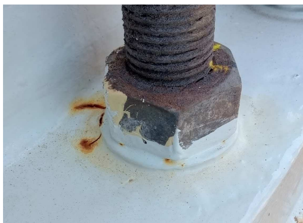
Figura 52 - Quebra de Tinta em Volta das Arruelas
