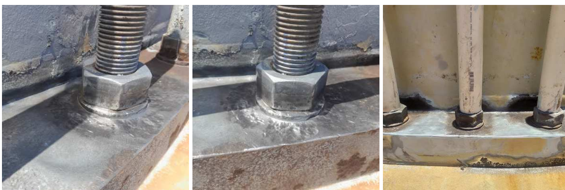
Figura 29 - Base com Tratamento Finalizado.
