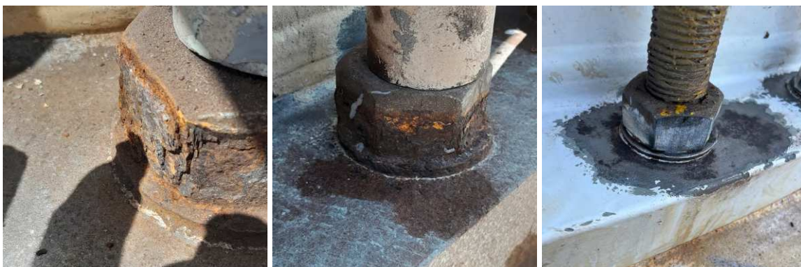
Figura 26 - Remoção da Camada mais Espessa de Oxidação.
