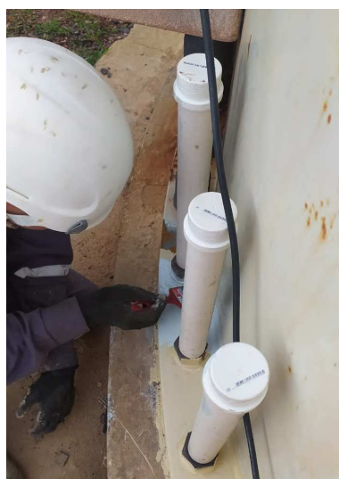
Figura 37 - Aplicação de Acabamento com Trincha.
