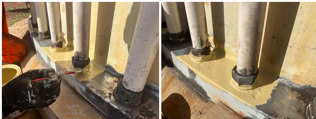
Figura 31 - Aplicação do Protetivo de Fundo com Trincha.
