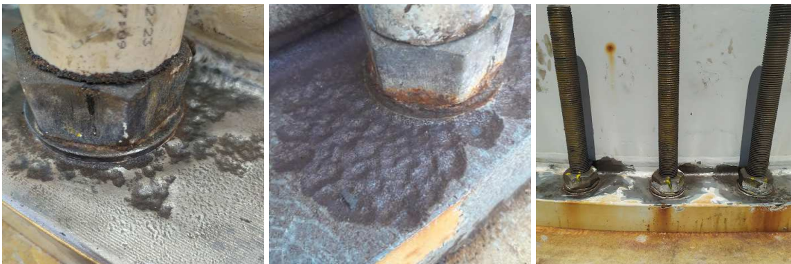
Figura 27 - Base em Processo de Finalização do Tratamento.
