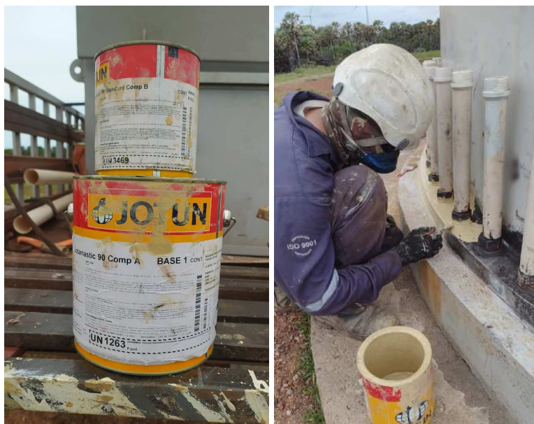
Figura 30 - Identificação e Aplicação do Protetivo de Fundo.
