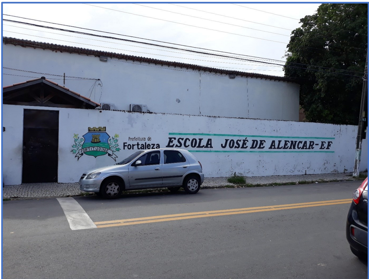
Figura 2 - Fachada da Escola Municipal José de Alencar, Fortaleza, Ceará, 2019.
