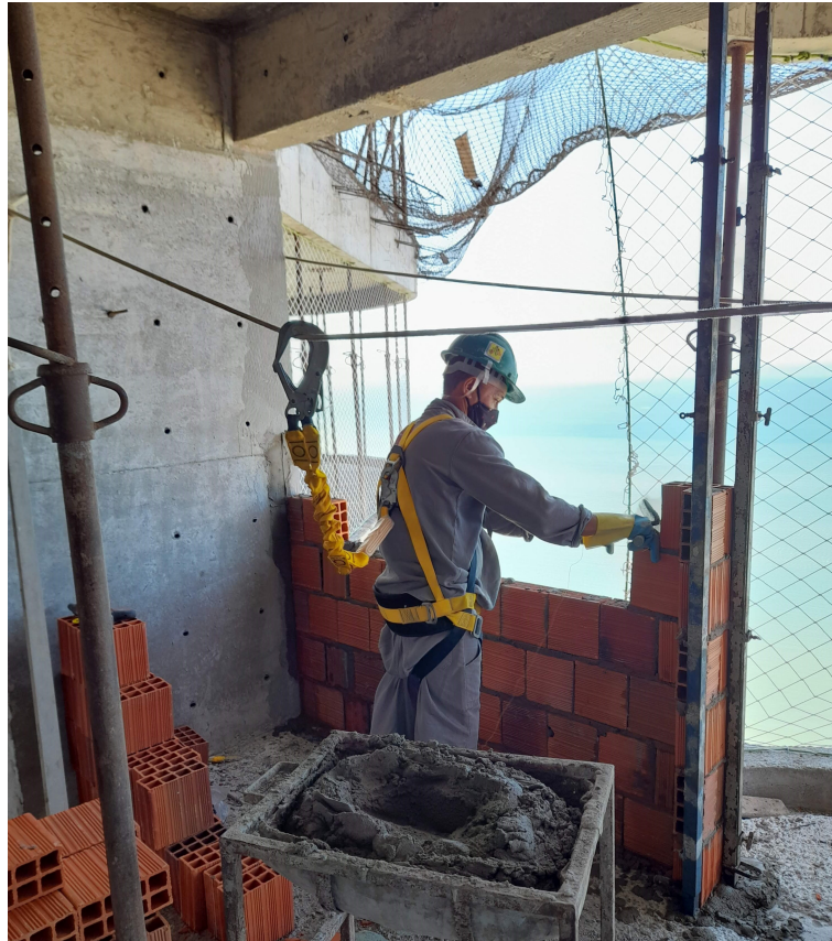
Figura 18 – Execução de Alvenaria
