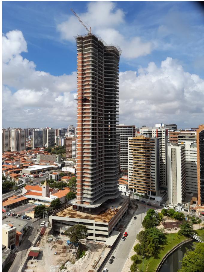
Figura 14 – Vista da obra
