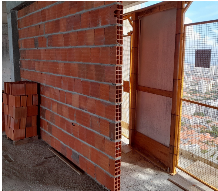
Figura 16 – Alvenaria tipo 1/2 vez
