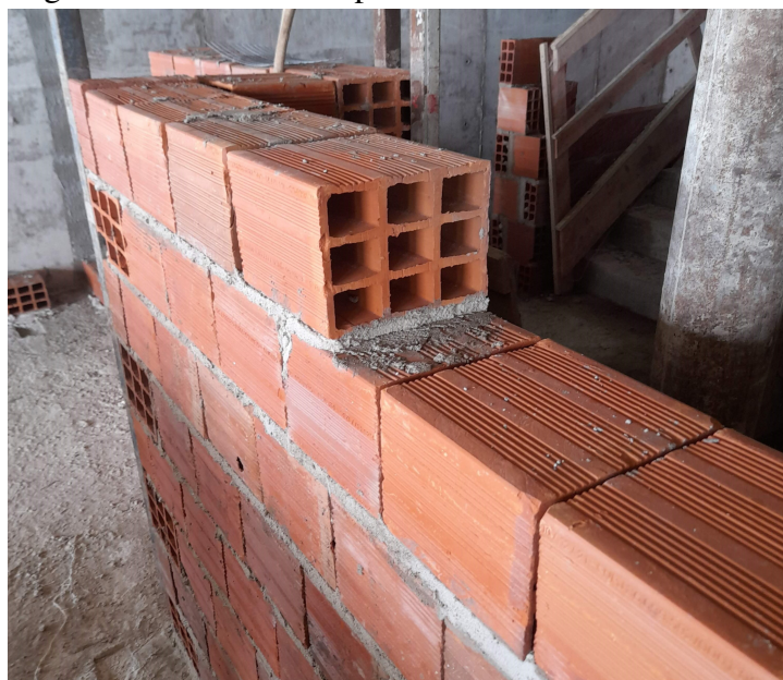
Figura 17 – Alvenaria tipo 1 vez
